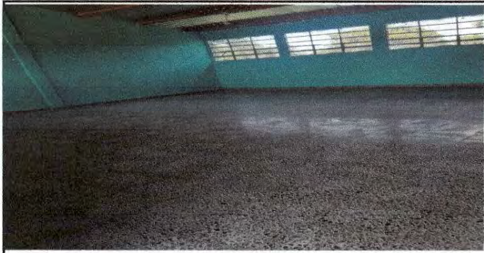
Foto 1: Finalización de piso de cemento en piso de granito.
