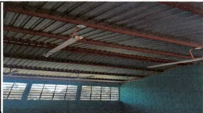
Foto 1: Finalización de lámina troquelada aluzinc calibre 26.
