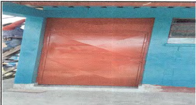
Foto 4: Finalización de puerta.
