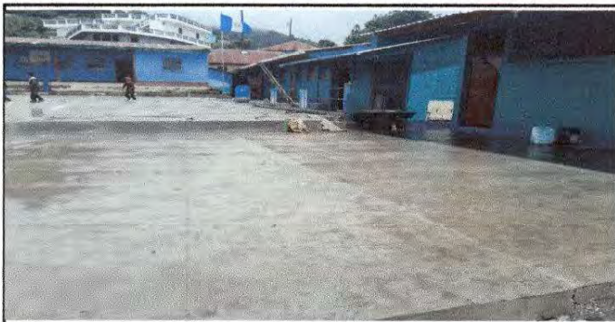
Foto 3: Finalización de pinturas en muros interiores e exteriores.
