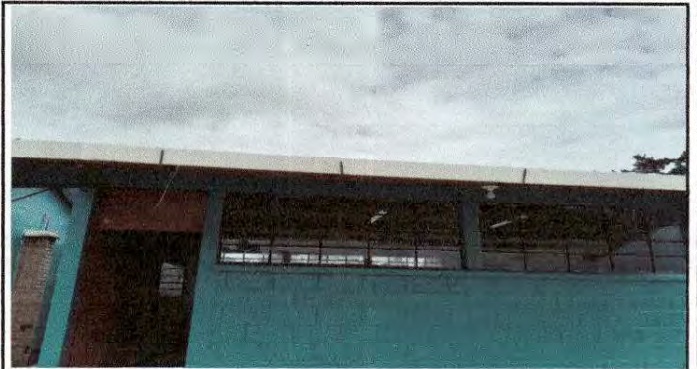
Foto 2: Finalización de canales y bajadas de agua.
